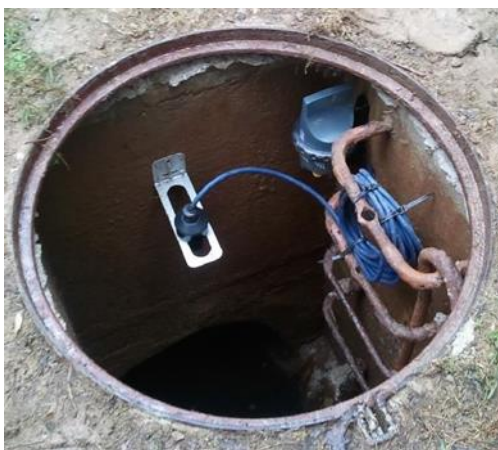
Рисунок 3 - Пример монтажа АП в колодце
